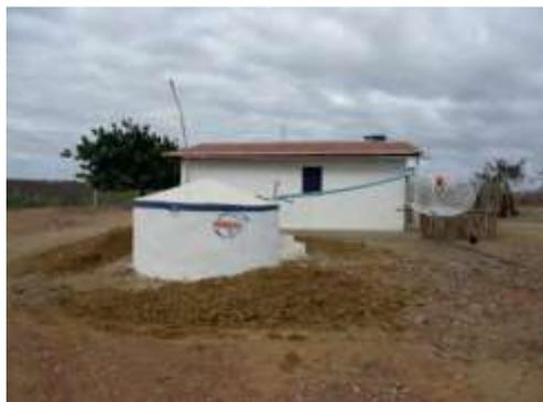
Em placas de concreto com bomba manual de PVC
