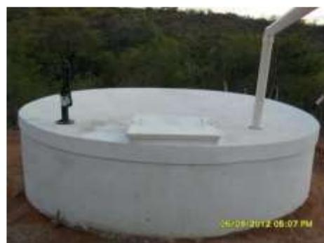
Em placas de concreto com bomba manual
